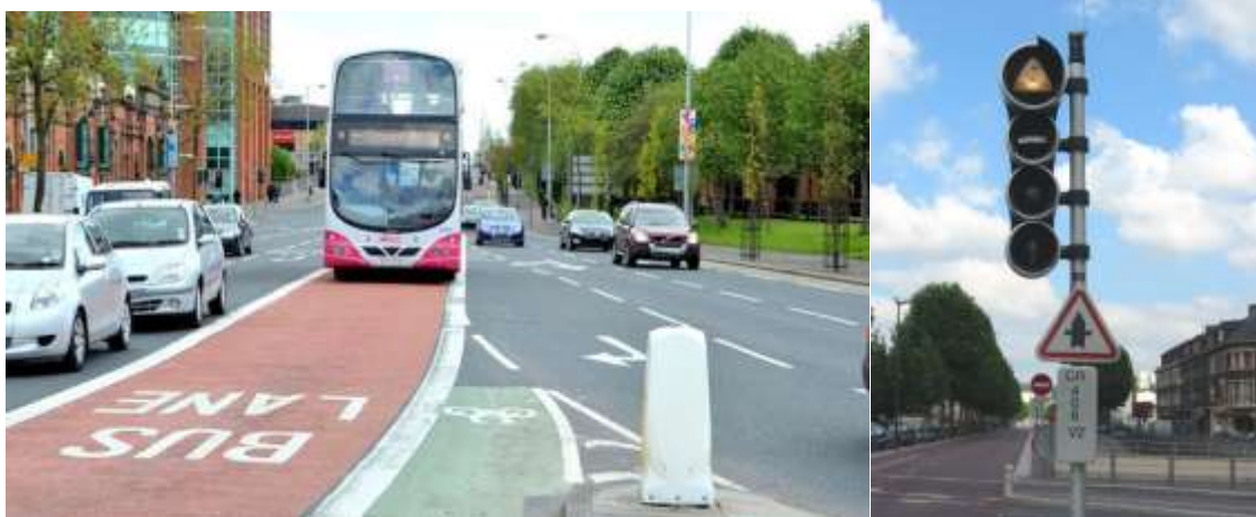
Figura 125: (stânga) Exemple de benzi dedicate de autobuz în Belfast, UK (source: www.geograph.ie). (dreapta) Sistem de prioritizare în intersecții a transportului public în Rouen, France (source: CREA)
