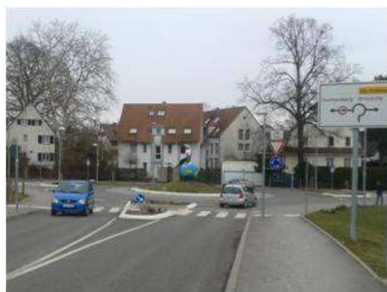
A4.Figura 15:Exemplu de sector de stradă cu semnalizare verticală corespunzătoare, Germania (Sursă: F.A.Burlacu, Influența caracteristicilor drumului asupra siguranței circulației rutiere, Teză de doctorat, 2014)
