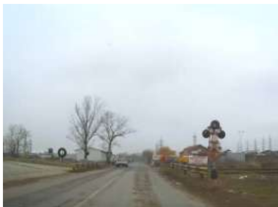
A4.Figura 33:Exemplu de trecere la nivel cu calea ferată amenajată necorespunzător, Iași, Șoseaua Iași-Tomești
