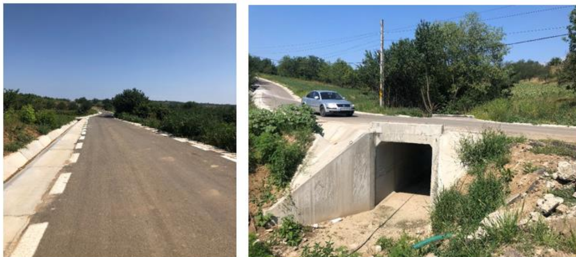
Strada Speranței și podet casetat Chicerea – finanțat prin Programul Național de Dezvoltare Locală (PNDL 2)
