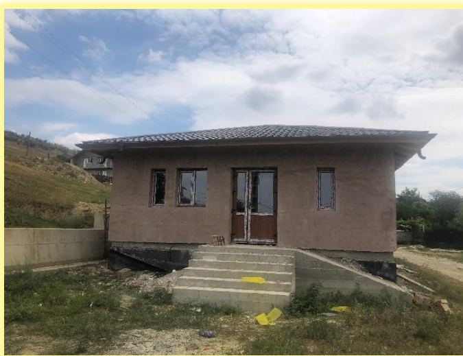
Dispensar în construcție, sat Vlădiceni (realizat din fonduri locale)
